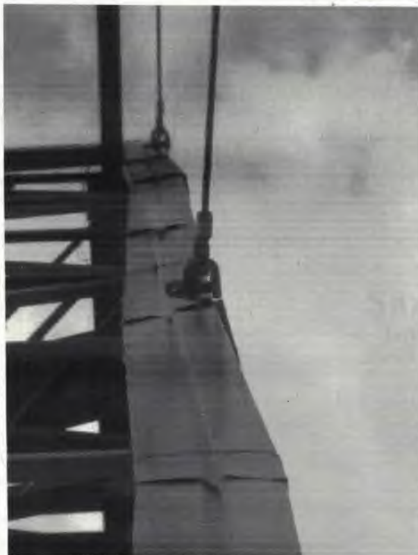
Figura 8 – Locais de fixação dos cabos de aço com a estrutura do pórtico
