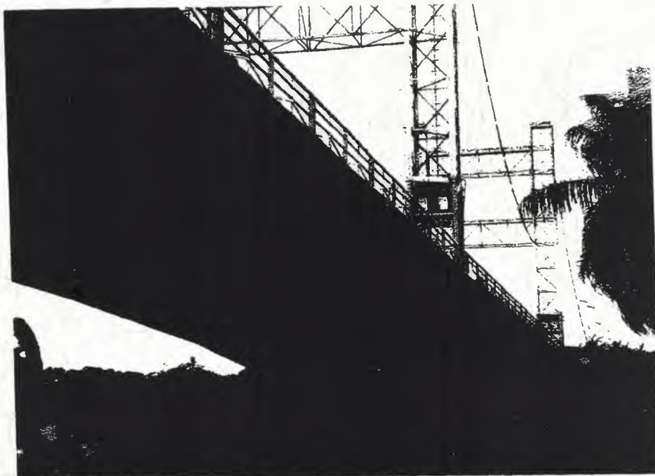
Foto 10 – Pórticos apoiados sobre lajes em balanço da ponte, promovendo esforços provavelmente não previstos na estrutura de concreto.
