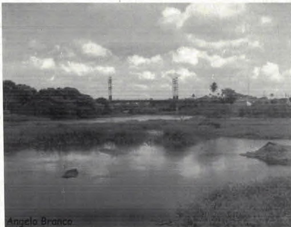
Figura 3 – Vista lateral da ponte (Fonte: Google by Angelo Branco)
