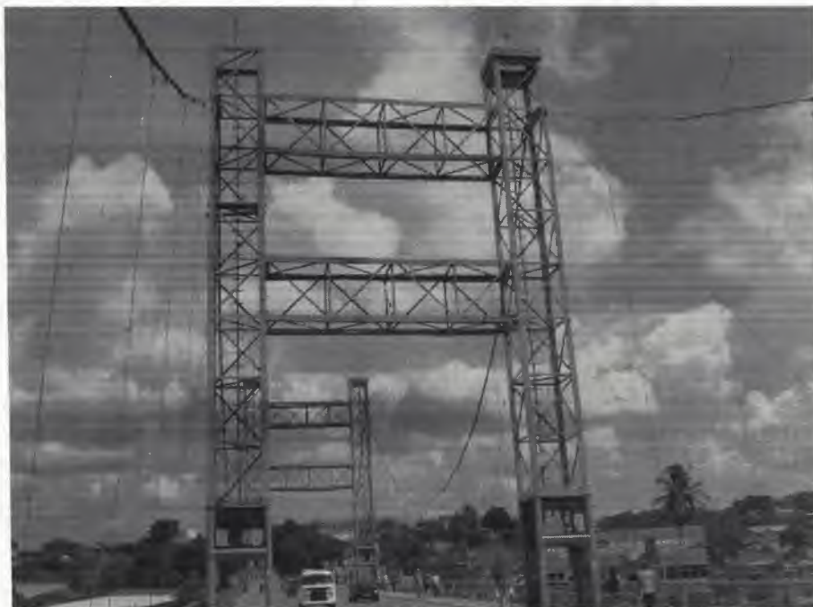
Figura 4 – Vista geral da ponte e dos pórticos metálicos
