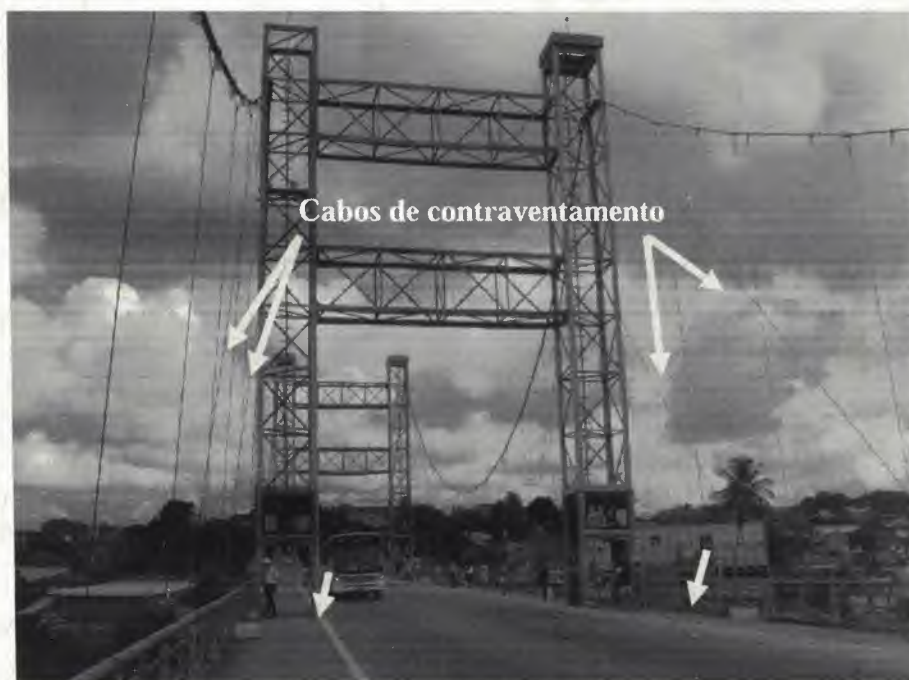
Figura 6 – Passeio de pedestres sem proteção de barreiras de segurança
