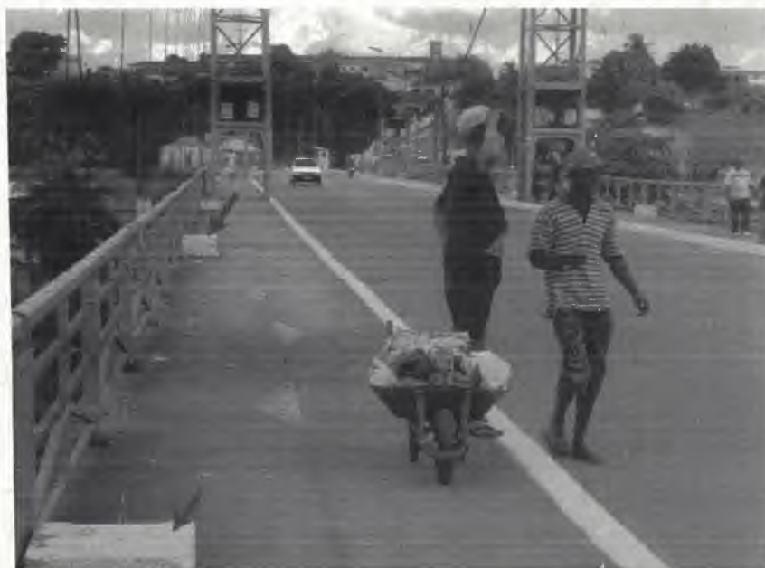
Figura 11 – Antigos blocos de fixação dos postes de iluminação
