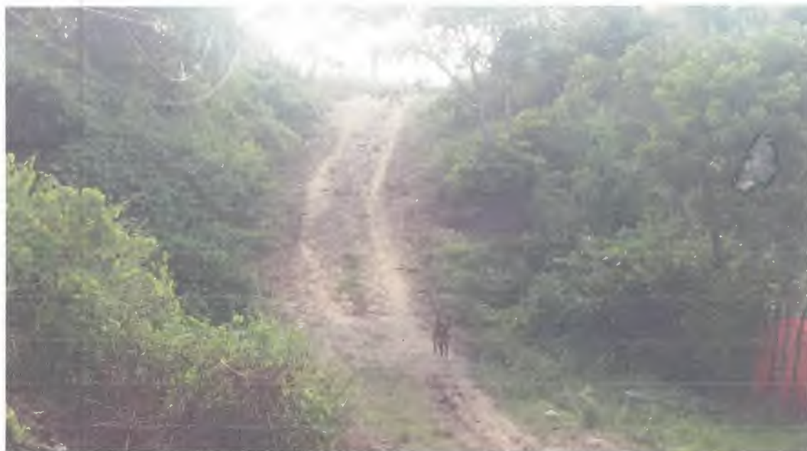
Falta de pavimentação asfáltica e saneamento básico
